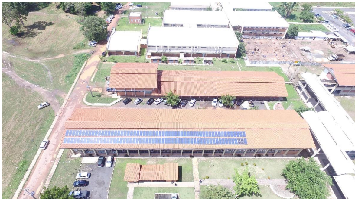
Figura 01 – Imagem área do Centro de Tecnologia – UFPI, com as placas fotovoltaicas Fonte – Arquivo Prof. Marcos Lira (UFPI)
